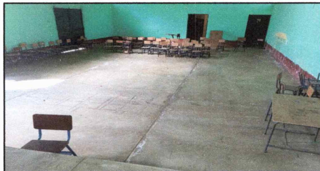
Foto 5: Instalación de piso ceramico del salón de usos multiples.
